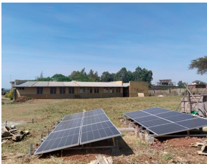
Fotografia del generador fotovoltaic instal·lat a l'escola d'Abay Mado
